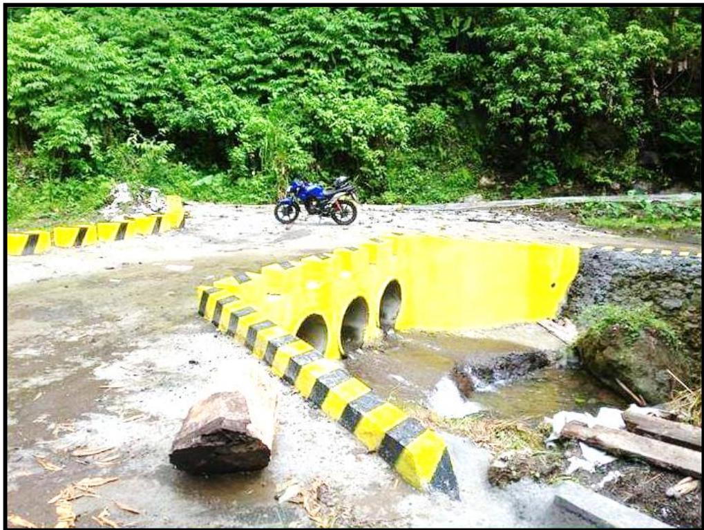
Spillway Bridge at Barangay Malayanan, San Fernando, Bukidnon
