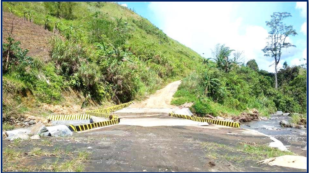
Spillway Bridge at Barangay Dao, San Fernando, Bukidnon
