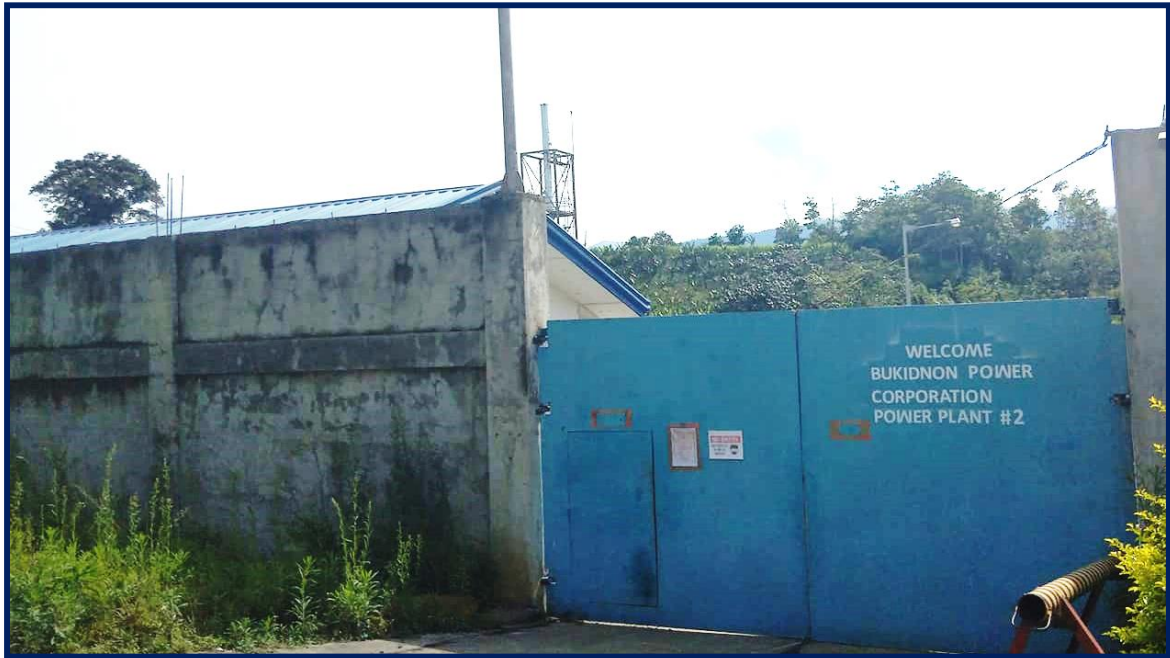
Power Plant @ Barangay Mabuhay, San Fernando, Bukidnon
